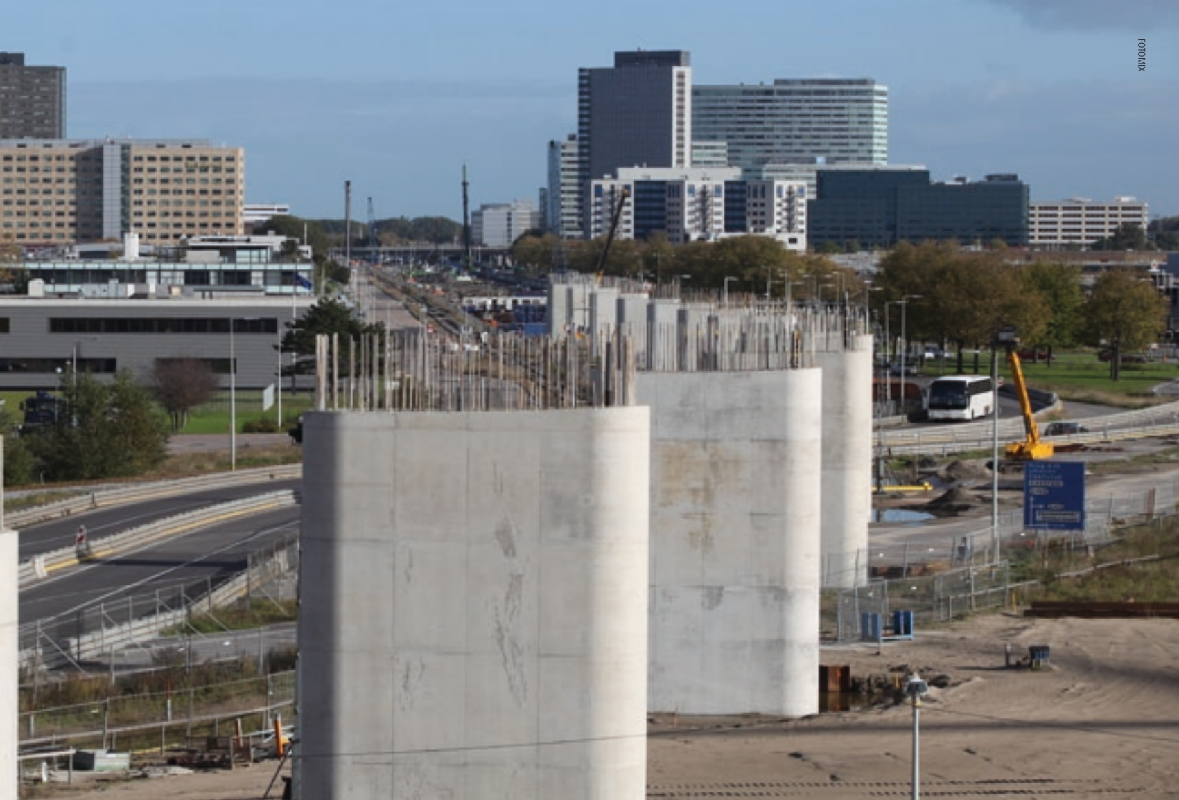
De Westrandweg, een onderdeel van de A5 tussen knooppunt Raasdorp en de A10.
